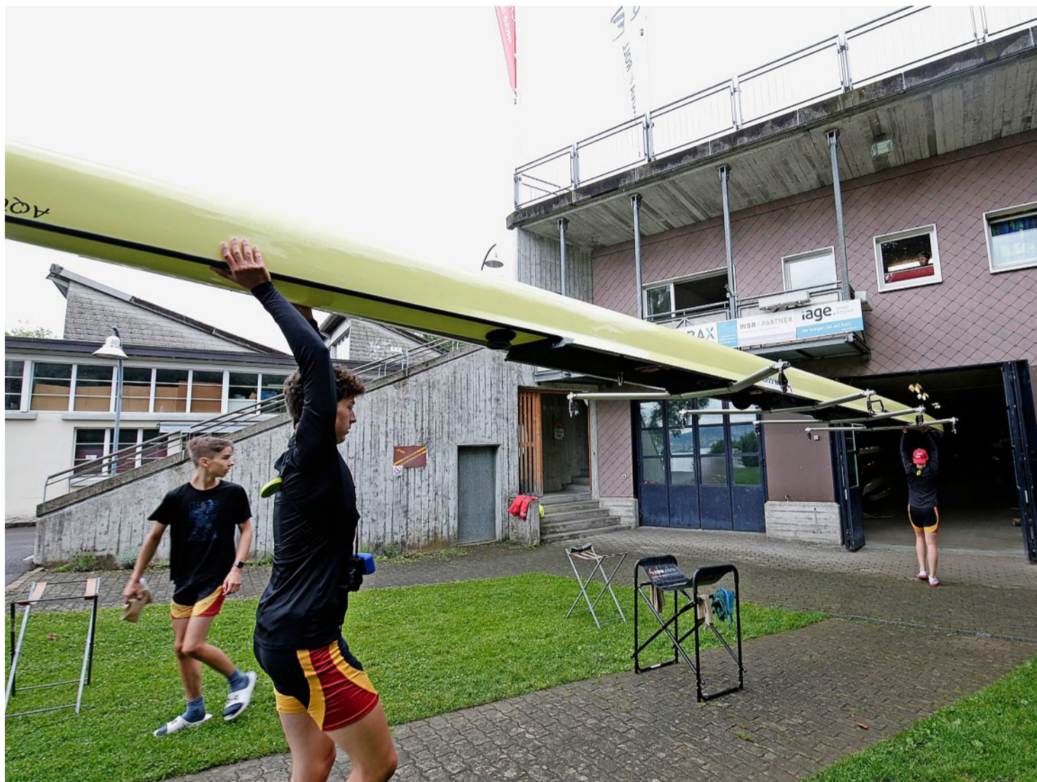
Das Clubhaus des Seeclubs platzt aus allen Nähten. Ein Anbau bis zur Treppe der Brücke würde Abhilfe schaffen. Foto: Moritz Hager
